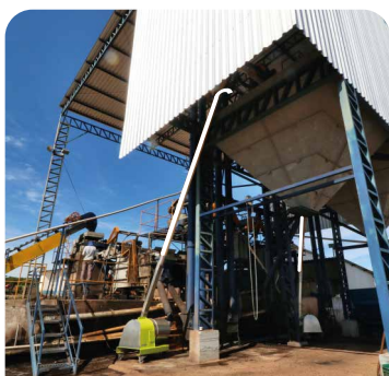
MOEGA E SILO ELEVADOS
