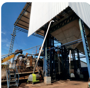
MOEGA E SILO ELEVADOS
