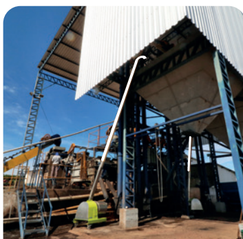
MOEGA E SILO ELEVADOS
